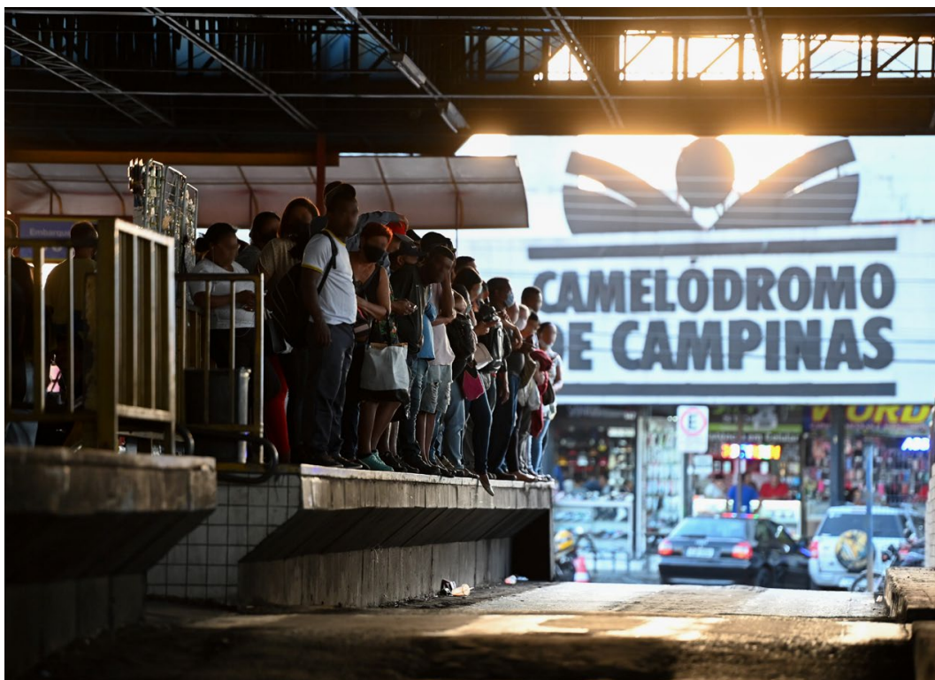
Figura 5.9: Terminais de integração desgastados
